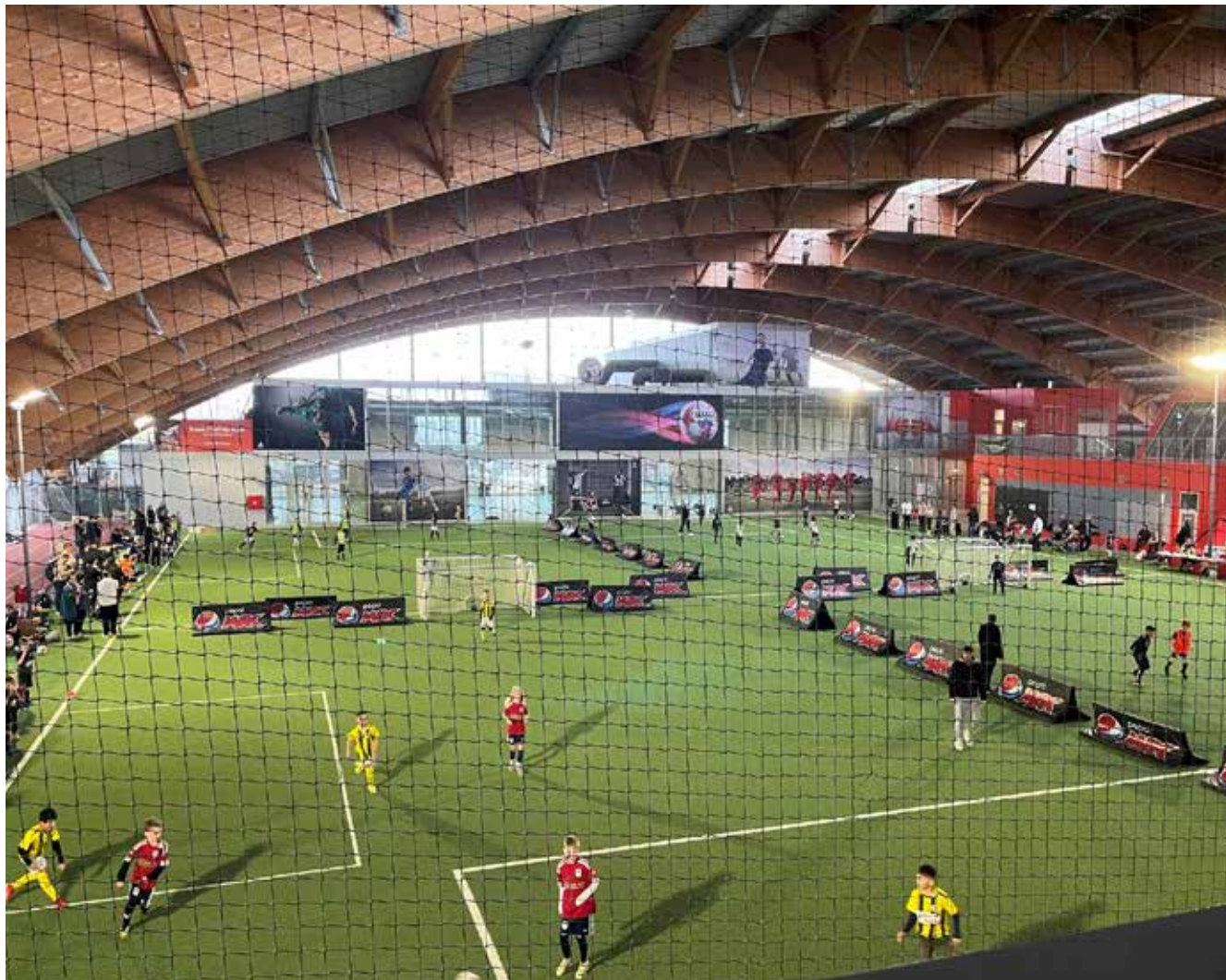
Hafniahallen, som kan bruges som et forbillede for en multihal i Amager Øst
