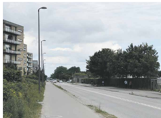
Der kommer nyt fortov på Amager Strandvej Foto: Amager Øst Lokaludvalg.
