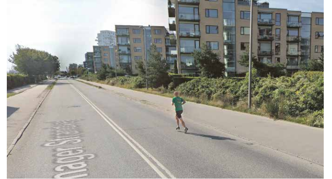
Et fortov vil blive etableret på Amager Strandvej på strækningen mellem Øresundvej og Øresund Parkvej i forbindelse med den nye supercykelsti. Foto: Google Streetview, Amager Strandvej
