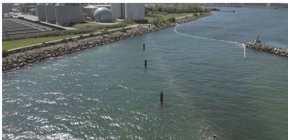
Lynetteholms perimeter nær Trekroner, som er tæt på vandoverfladen. I baggrunden ses flydespærre (røde gajer), der af sikkerhedsmæssige årsager lukker af for gennemsejling. Foto: By & Havn
