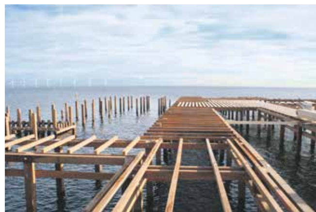
Det ny Helgoland under opbygning
