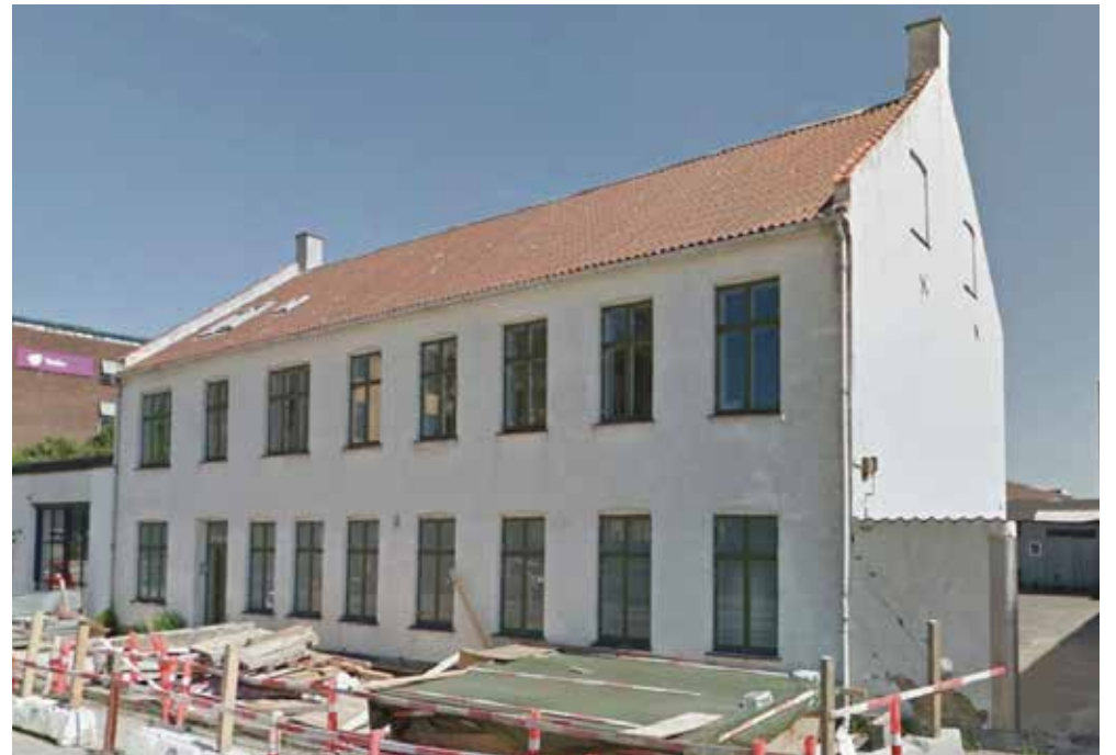
■ Sådan så huset ud for nedrivningen.
