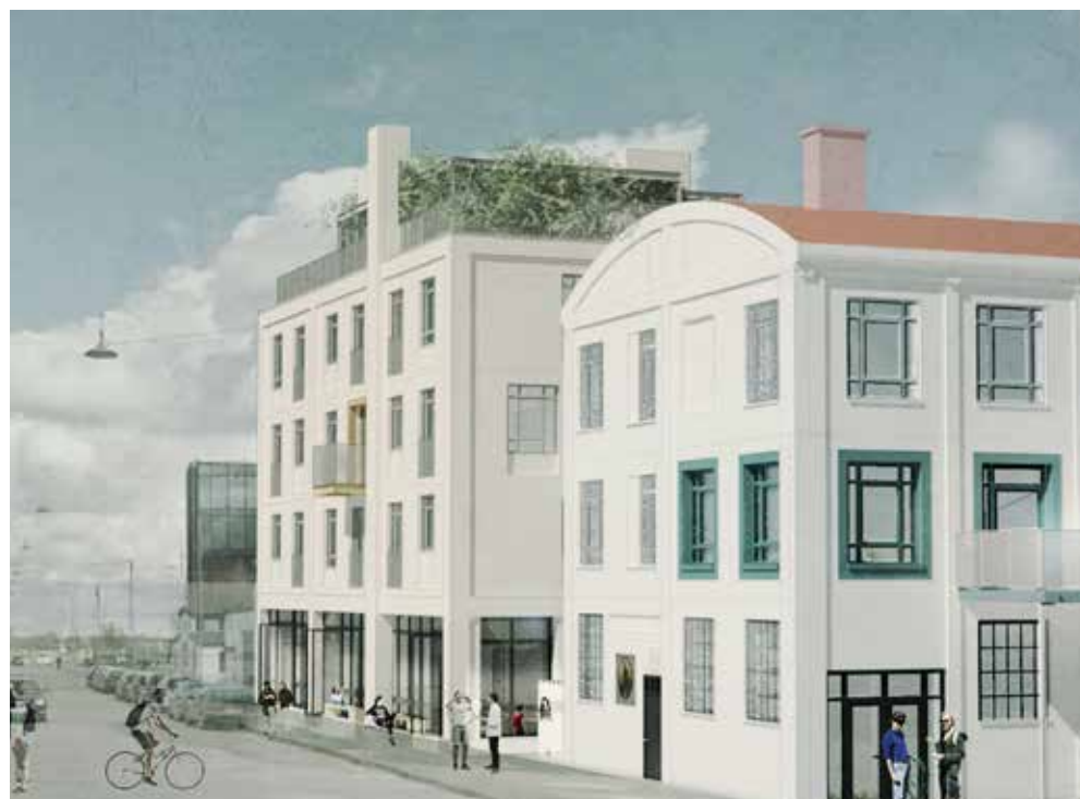
Renovering af det gamle filmlager og ny bygning på Strandlodsvej 3. Set fra hjørnet Strandlodsvej/Lindgreens Allé.
