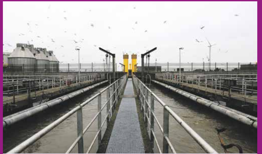
Lynetten, Danmarks største rensningsanlæg for spildevand. Foto: Rikke Colburn
