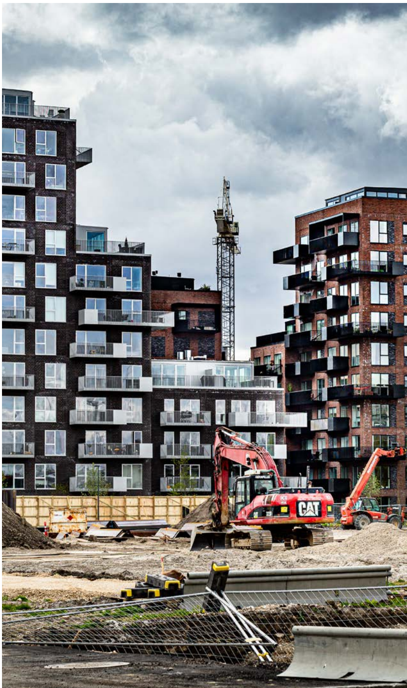
Byggeri ved Strandlodsvej. Foto: Yann Houlberg Andersen
