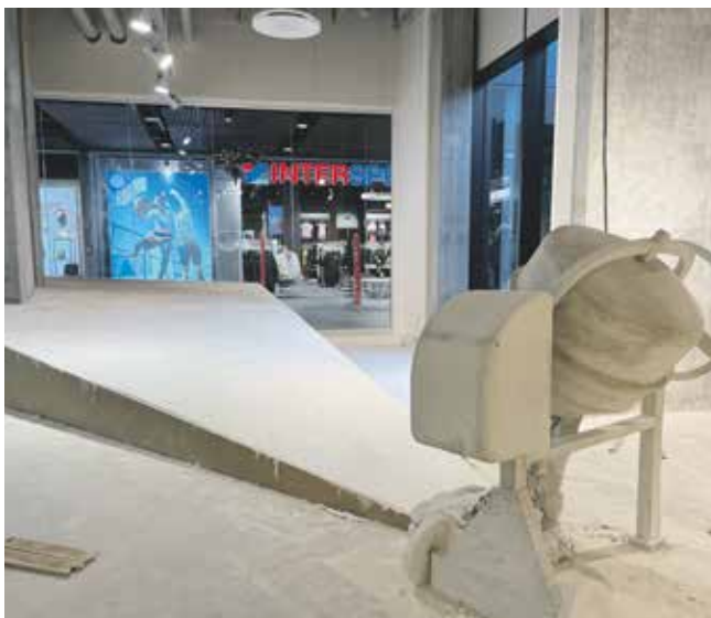
■ Siska Katrine Jørgensens betonblander set i butikslokalet i Amager Centret. Foto: Charlotte Malte
